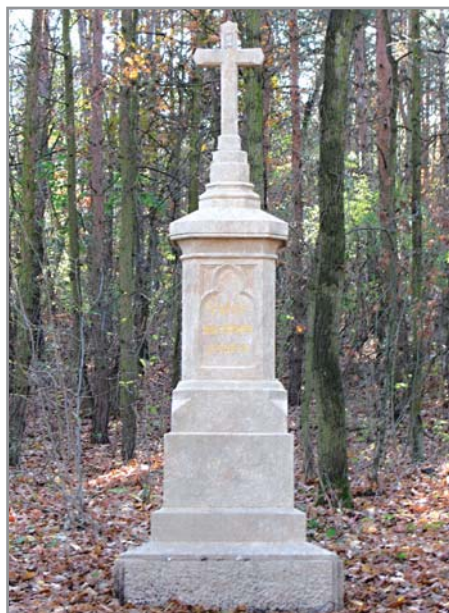
Kříž na Rěně byl opraven v roce 2015
