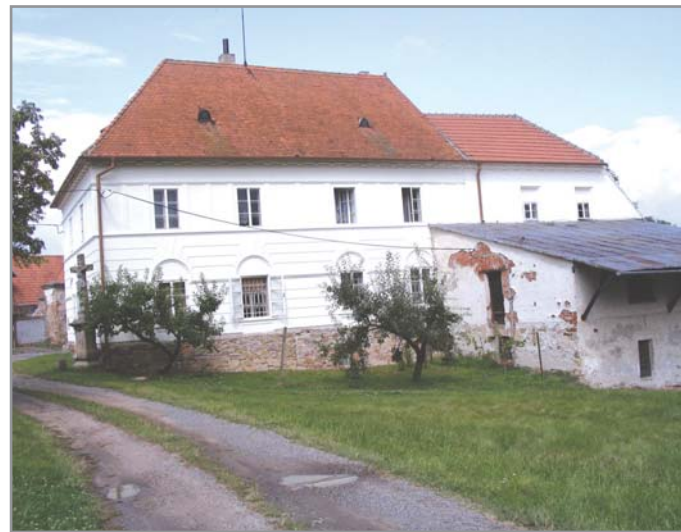
Budova mlýna. Vlevo je kříž z roku 1808.
