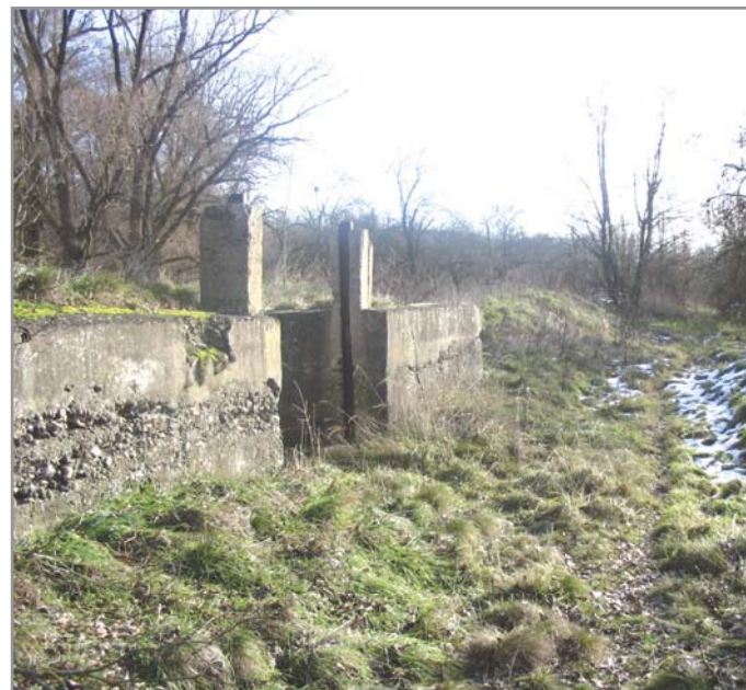
Bývalý náhon ke mlýnu, vlevo stávek (Flusárna).
