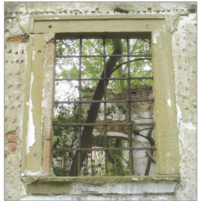
Alinkov - pískovcové ostění oken budovy mlýna
