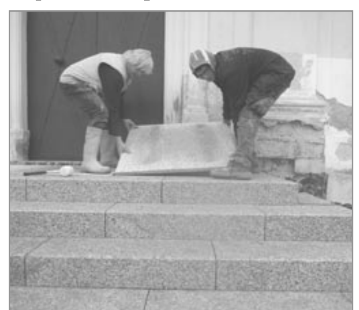
Pokládka poslední desky na novém schodišti
