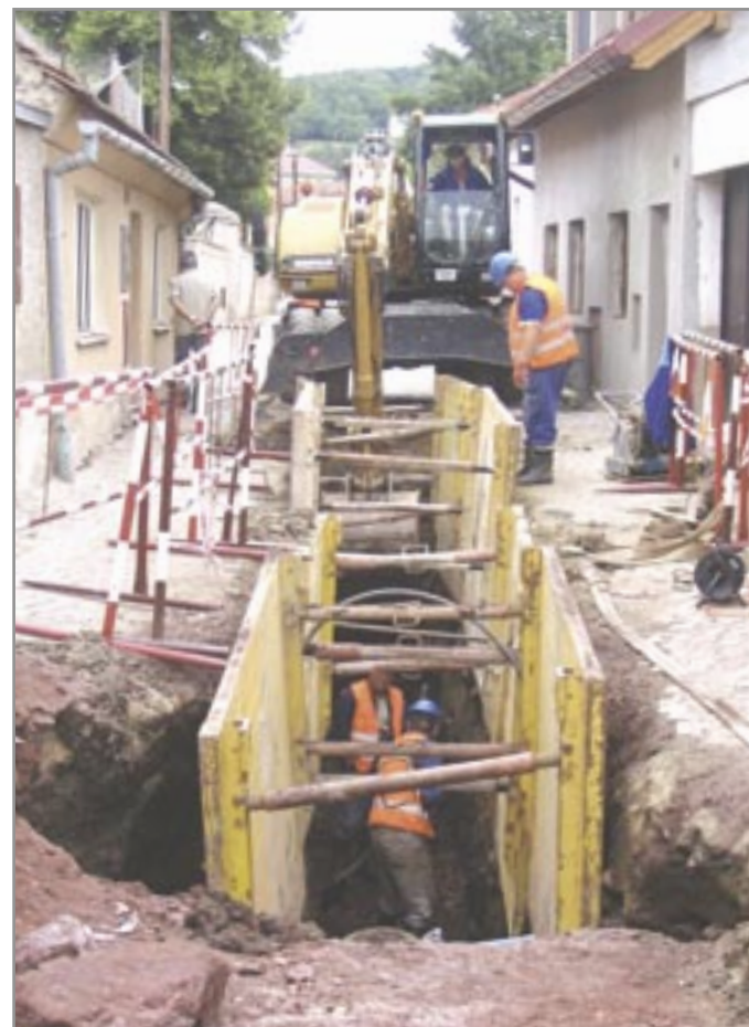
Rekonstrukce kanalizace v Chřestové ulici
