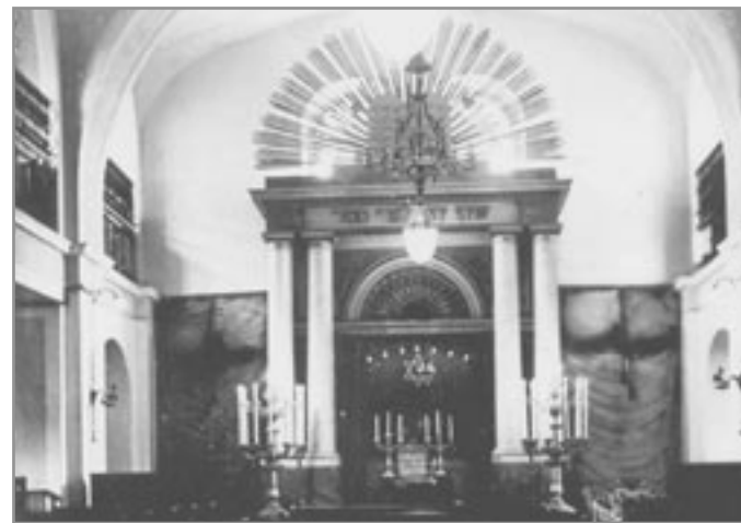
Dřívější interiér synagogy v Ivančicích
