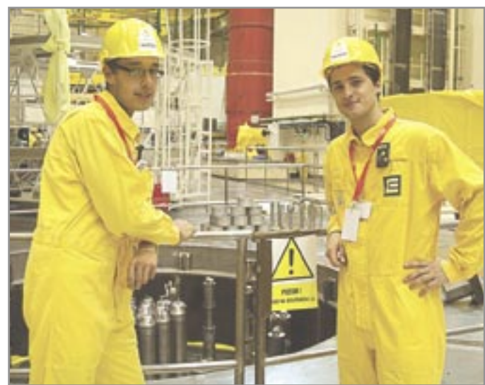
Jakub Klíma a Jakub Veselý z Ivančic nahlédli i do právě odstaveného prvního reaktového bloku elektrárny. Foto: JAS
