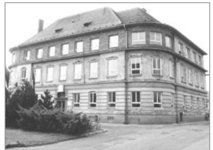
Budova školy v devadesátých letech minulého století
