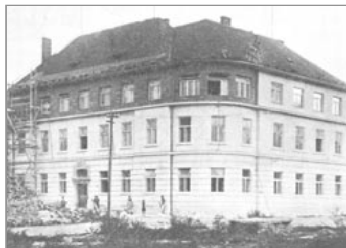
Budova Okresního národního výboru po opravě v roce 1946
