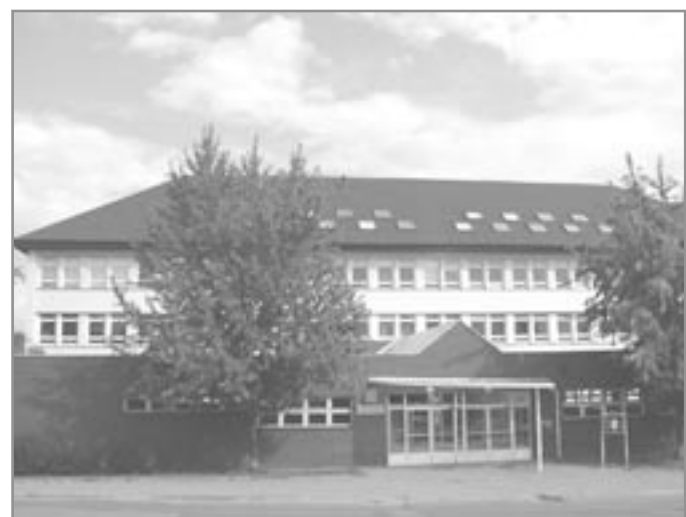
Budova gymnázia v současné době
