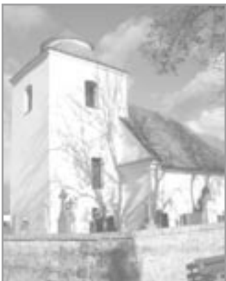
Kostel sv. Leopolda
