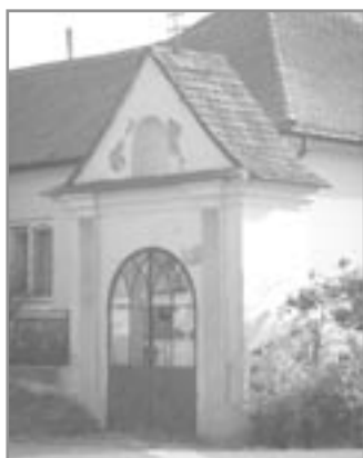
Kaplíčka na křižovatce
