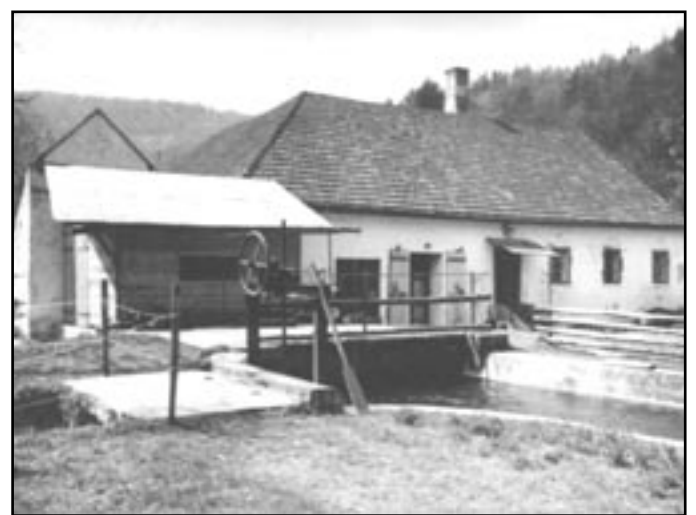
Pohled na mlýn přes náhon.
