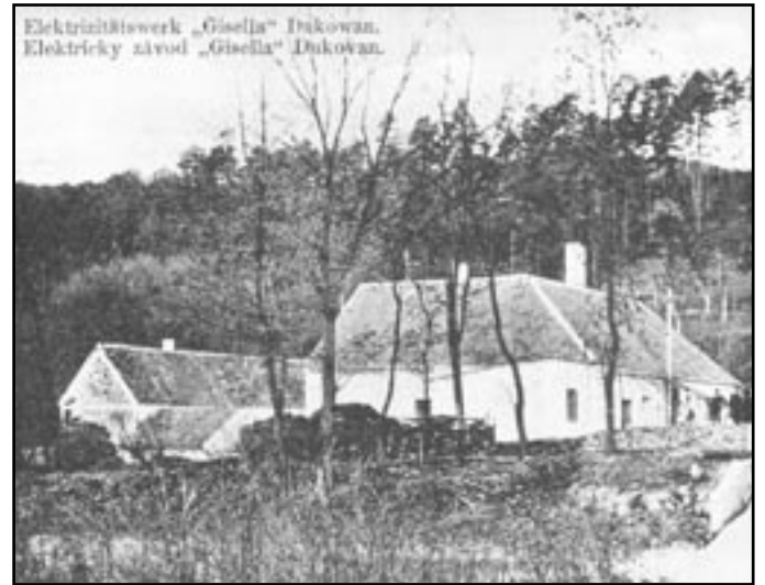
Pohled na závod Gizela. Pohlednice z roku 1915
