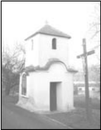
Kaple sv. Gottharda
