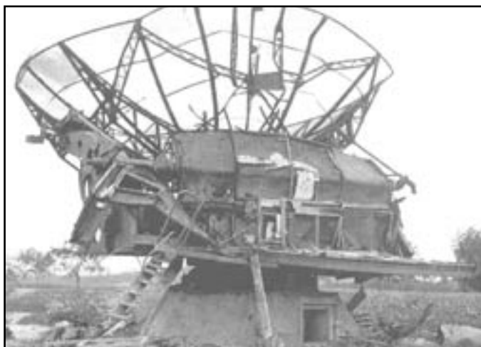
Zničený radar WITZBURG RIESE
