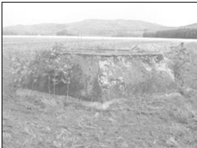
Sokl po radaru - je vidět asi 50 metrů od silnice
