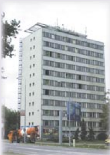
Revitalizace výškového domu
