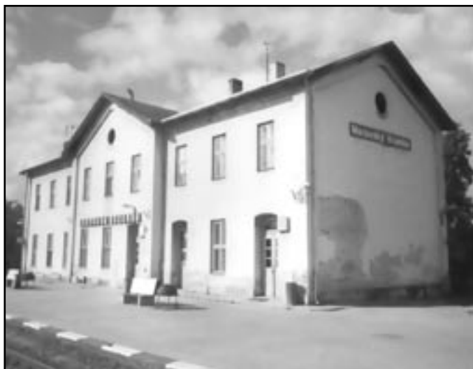
Budova nádraží v Moravském Krumlově z roku 1870
