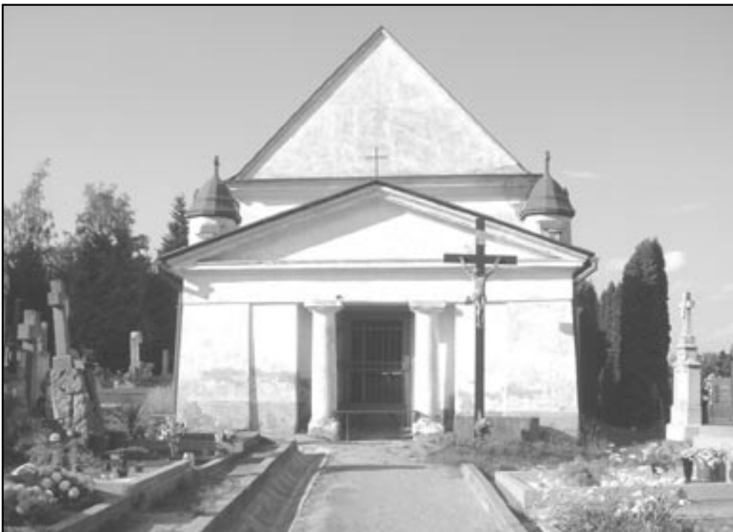
Hřbitovní kaple byla postavena ze zdiva zbořeného druhého bohutického kostela
