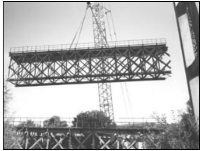
Demolice viaduktu - 5. září 1999
