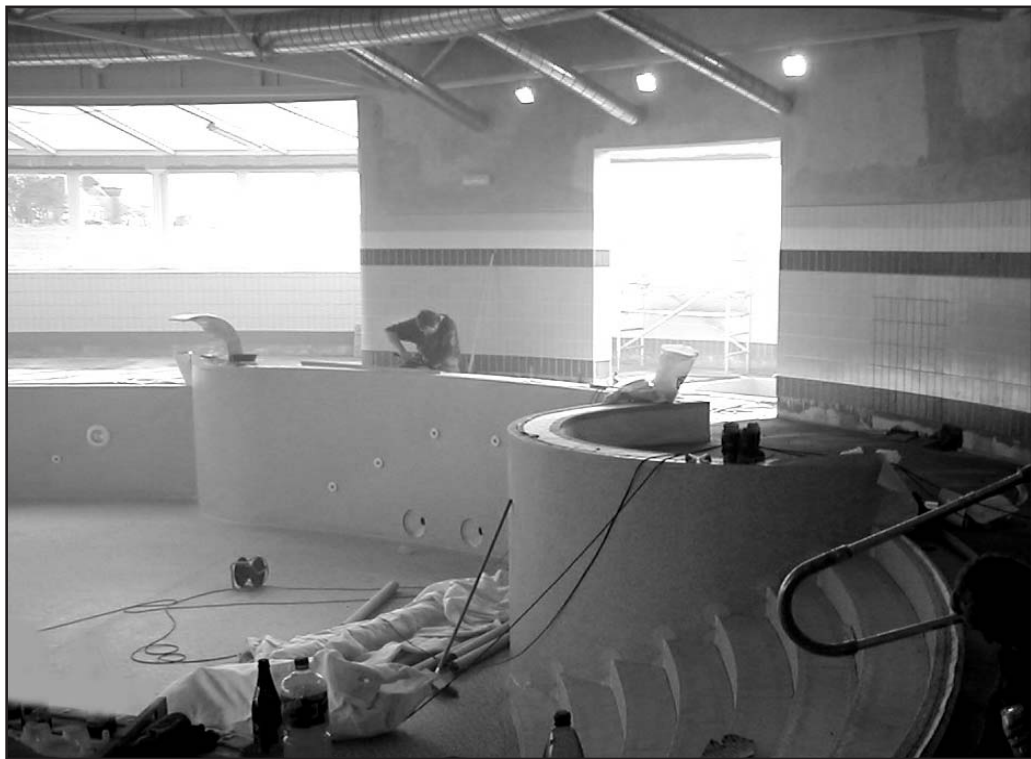
Stavba bazénu ve sportovním areálu v Nové Vsi vrcholů
